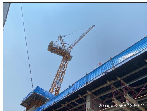
ภาพที่ 75 ควบคุมแขนบูมของเครนให้อยู่ในพื้นที่ก่อสร้าง
