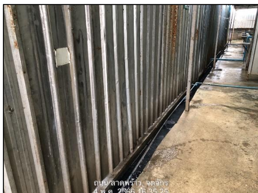
ภาพที่ 69 รางระบายน้ำ และบ่อดักตะกอนบริเวณบ้านพักคนงาน
